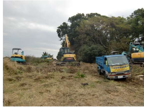
撤去作業中②
