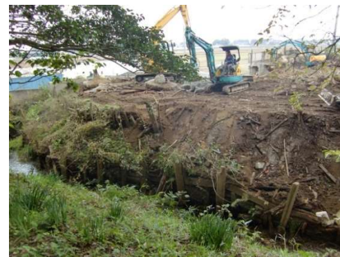
撤去作業中④
