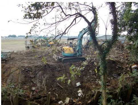
撤去作業中⑤
