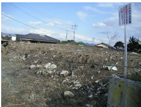
撤去作業完了①
