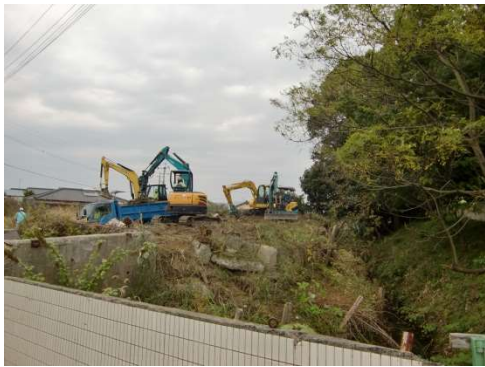
撤去作業中①
