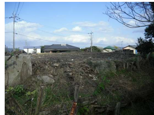
撤去作業完了②
