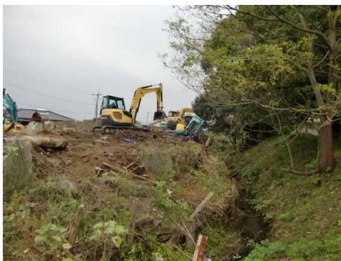
撤去作業中③
