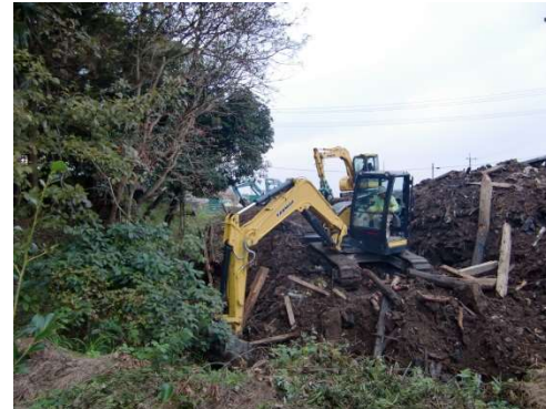
撤去作業中⑥
